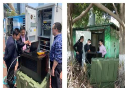
図 3.10 5G 基地局での給電保障測定
